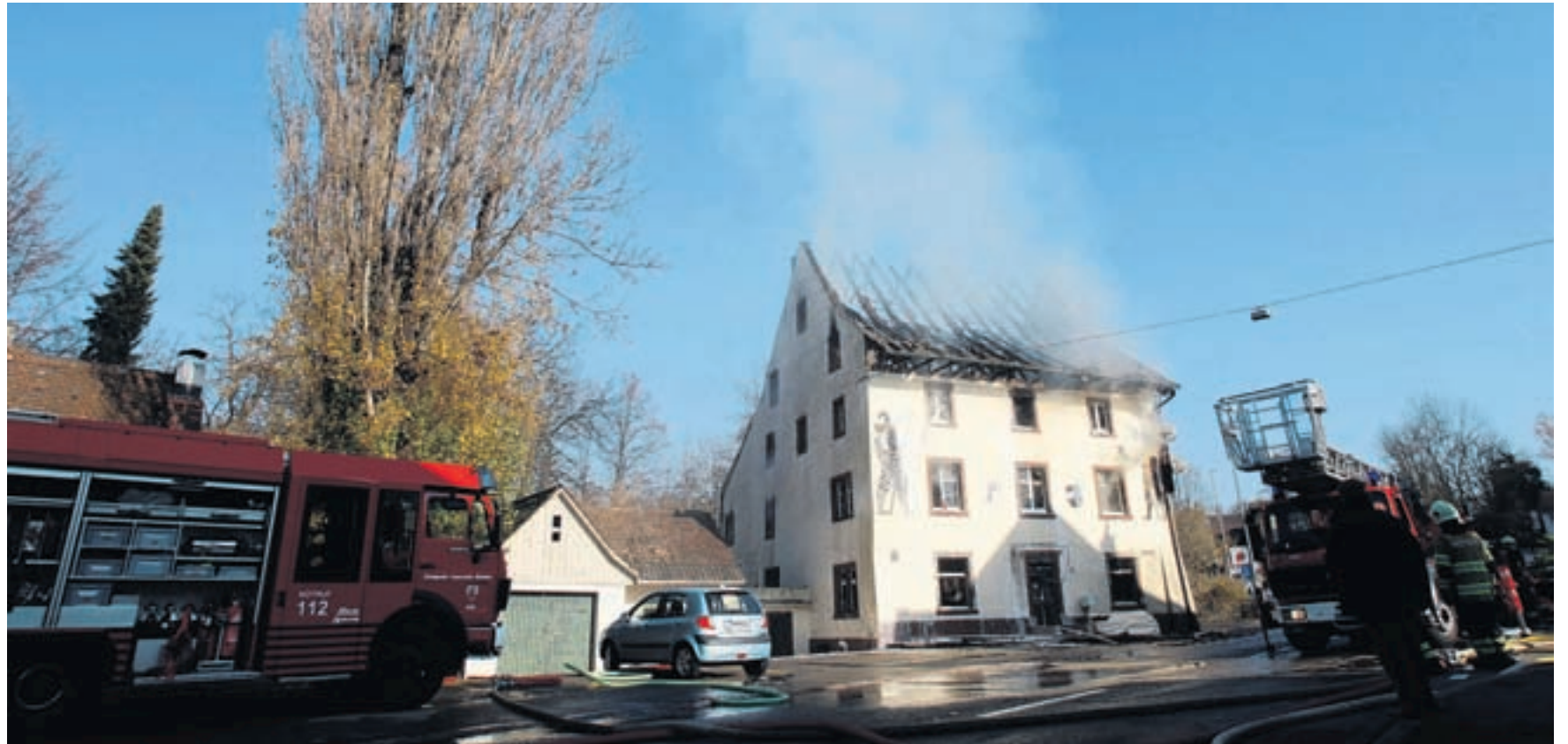
«Moulin Rouge» nach dem Brand. Bald drei Jahre später zeichnet sich endlich eine Lösung für die Liegenschaft an der Hauptstrasse 37 in Augst ab. Foto Keystone
